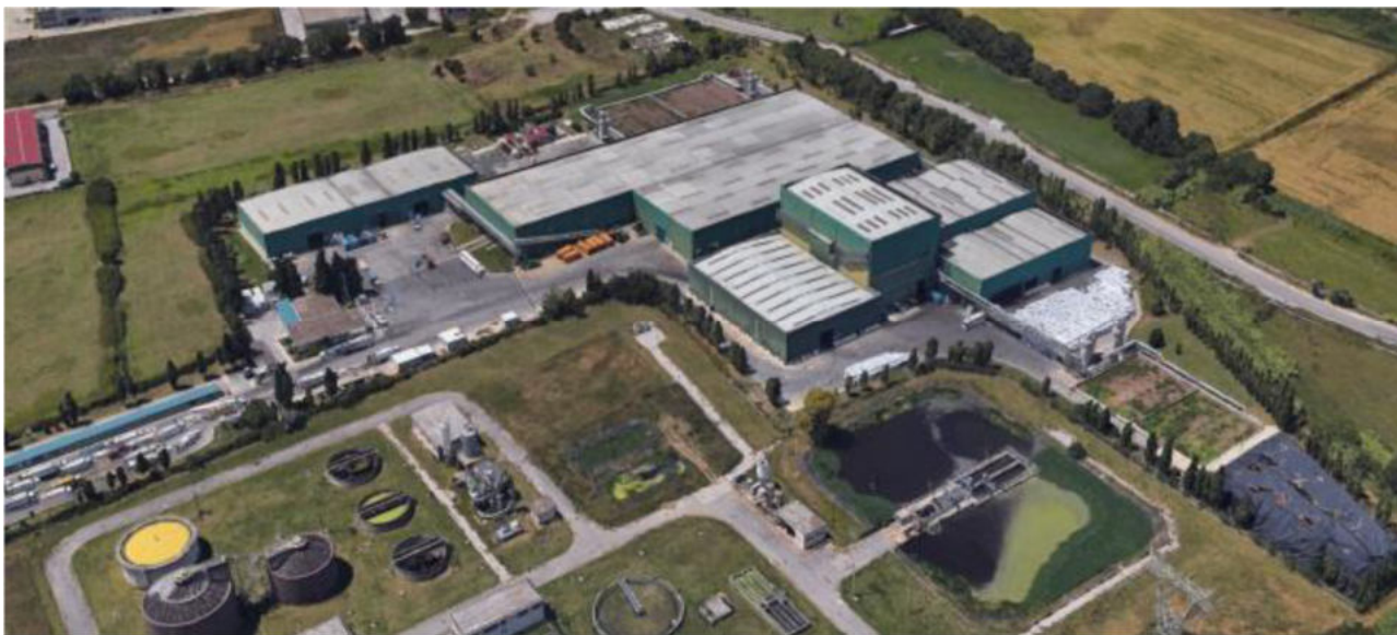
Figura 51: Vista aerea dell'impianto di trattamento meccanico biologico (TMB) di Battipaglia
