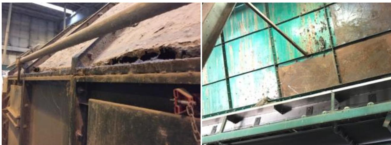
*Figura 26 -Pannellatura ammolorate o fessurate*
