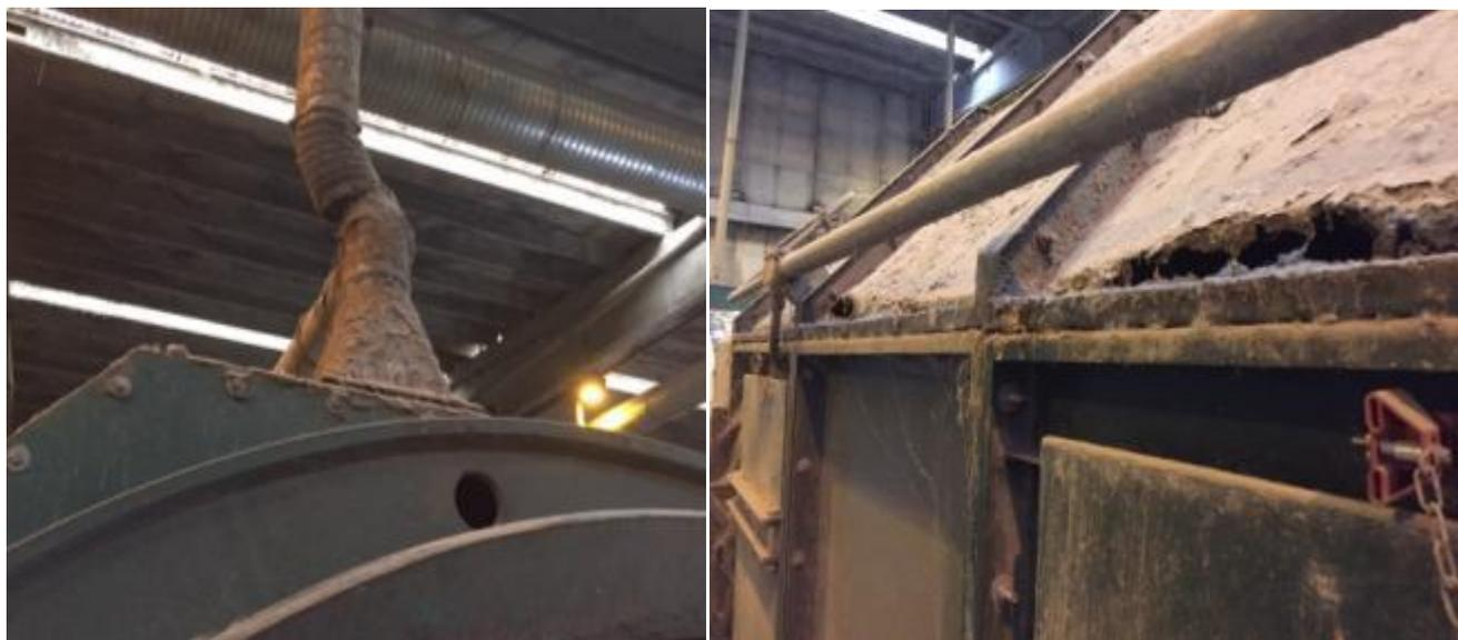
*Figura 36 -Cappe di aspirazione disconnesse e cappottature usurate*
