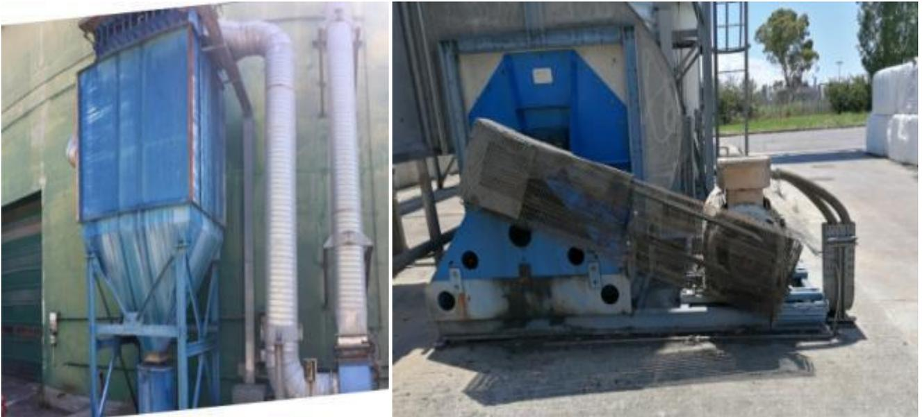
Figura 37 - Elementi in avaria: filtro a maniche BAF 501, scrubber SCR 502
